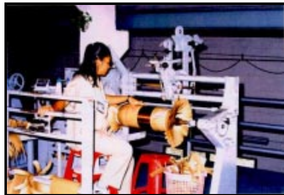
ภาพที่ 9 การพันขดลวดแรงต่ำและแรงสูงบนเครื่องพัน
