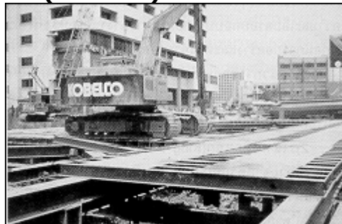
รูปที่ 9 รถขุดบนแผ่นเหล็กพื้น (Platform) กำลังขุดดิน
