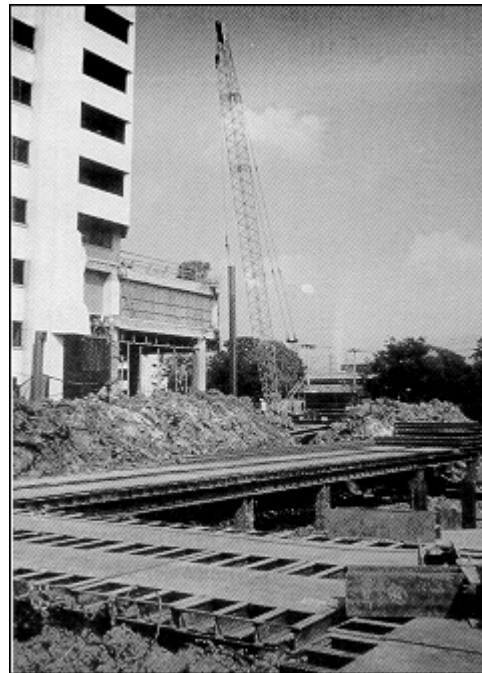
รูปที่ 8 แผ่นเหล็กพื้น (Platform) ที่วางบนเหล็กค้ำยัน (Strut) ชั้นที่ 1
