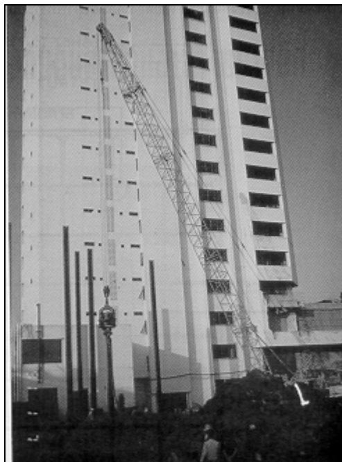
รูปที่ 4 เครื่องจักรกำลังปักแผ่นเหล็กพืด (Sheet Pile)
