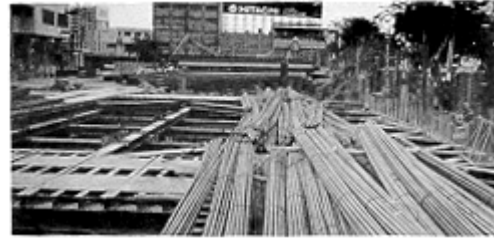
รูปที่ 6 เหล็กเสริมคอนกรีตในงานโครงสร้าง
