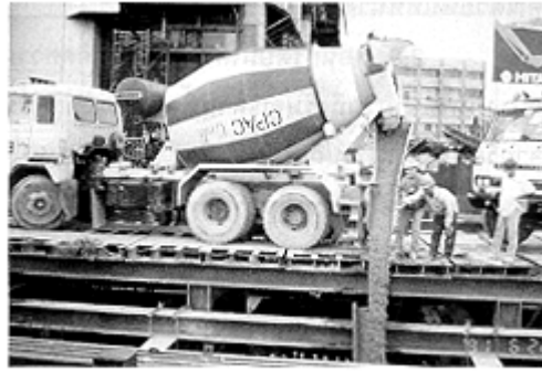
รูปที่ 4 งานเทคอนกรีตฐานรากขนาดใหญ่
