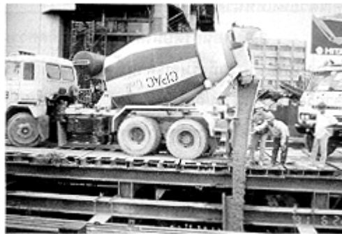
รูปที่ 4 งานเทคอนกรีตฐานรากขนาดใหญ่
