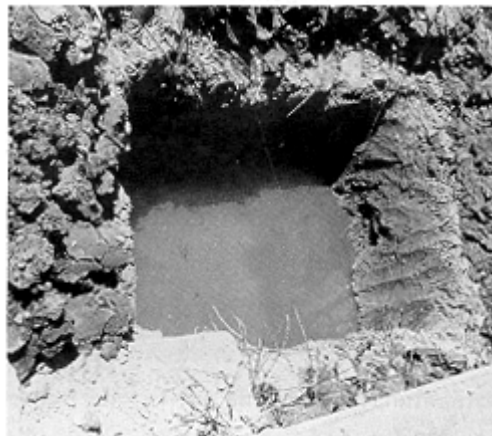
รูปที่ 1 การขุดดินสำหรับฐานรากเดี่ยว
