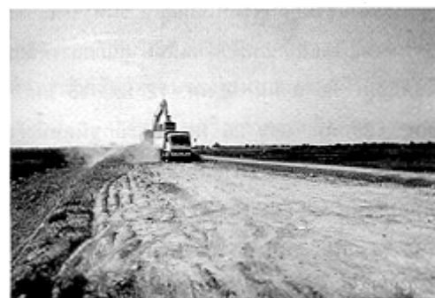
รูปที่ 3 งานถมดินเพื่อปรับระดับการก่อสร้าง
