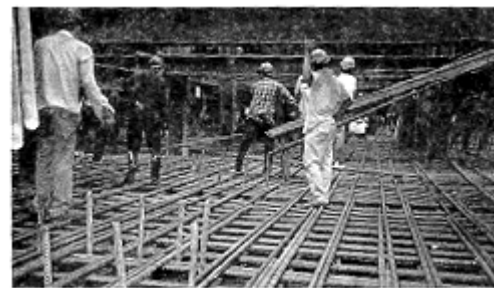
รูปที่ 7 เหล็กเสริมคอนกรีตฐานรากขนาดใหญ่
