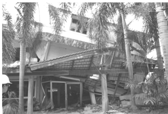
(ข) บ้านพักอาศัยบริเวณ 3 แยกแม่สรวย
