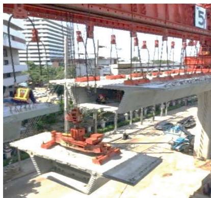
รูปที่ 1 เครื่องจักรติดตั้งแบบ Launching gantry
