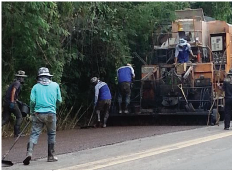
รูปที่ 1 งานก่อสร้างพาราสเลอริซิด
