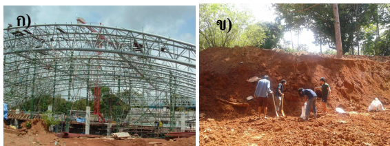
รูปที่ 1 ก) ฐานรากสระว่ายน้ำขุดลงไปดินที่ศึกษา และ ข) ลักษณะหน้าตัดของชั้นดินที่เก็บมาเป็นวัตถุดิบที่ใช้ศึกษา
