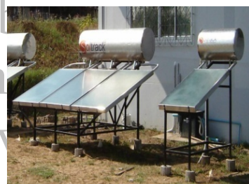
รูปที่ 10 ระบบทำน้ำร้อนแสงอาทิตย์แบบเทอร์โมไซฟอน
