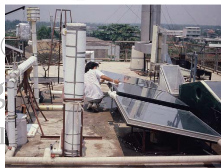
รูปที่ 17 ระบบทำน้ำร้อน ที่มีตัวเก็บสะสมความร้อนในรูปความร้อนแฝง [11]
