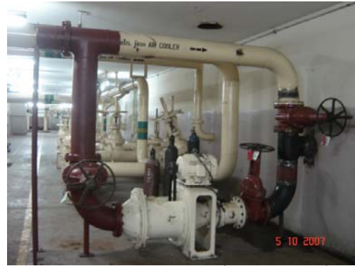
รูป 2 แสดงการเชื่อมต่อชุดกังหันน้ำเข้ากับวาล์วน้ำและท่อชุดใหม่แล้วเสร็จ
